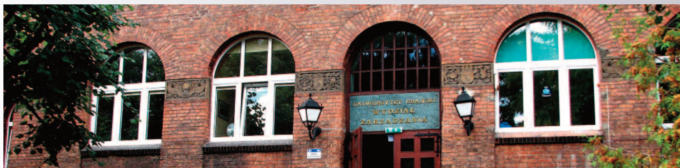
BUDYNEK WYDZIAŁU ZARZĄDZANIA UG, FOT. MAŁGORZATA ARMATYŃSKA
