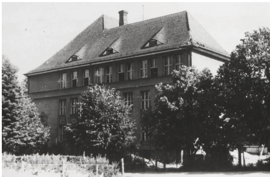
Budynek V Liceum Ogólnokształcącego w Gdańsku-Oliwie przy ul. Polanki, w którym mieściła się PWSP
