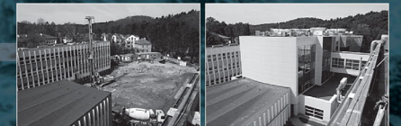
Rozwój infrastruktury - powstanie nowego budynku C Wydziału Ekonomicznego, marzec 2012 r. i kwiecień 2013 r.
