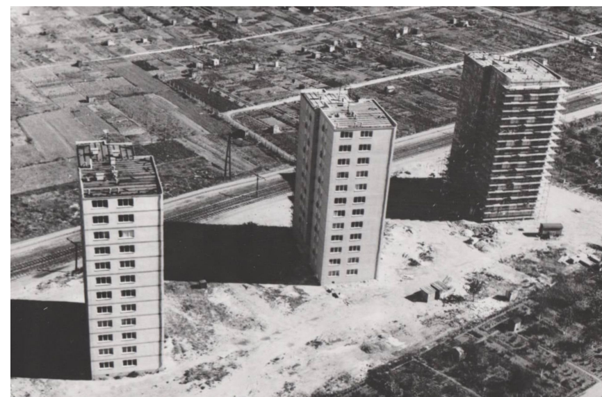
Ulica Wita Stwosza i bloki nr 52, 54, 56. Za blokami widok na ogrody działkowe, na terenie których niebawem rozpocznie się budowa Wydziału Humanistycznego, 1964 rok
