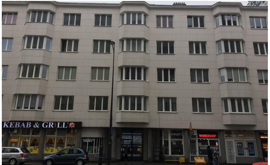
Kamienica na ulicy Żelaznej 89 dzisiaj
